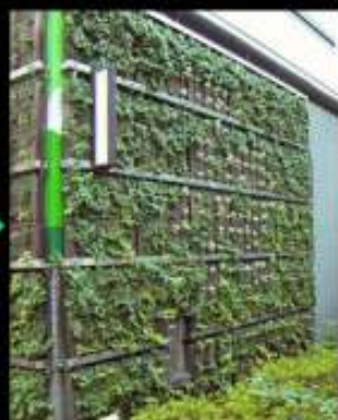
■ユニット型壁面システム緑化の経過の様子・・・東京、錦糸町駐車場にて壁面育成経過
