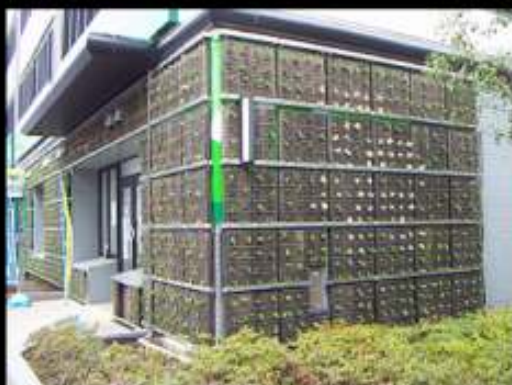
■ユニット型壁面システム緑化の経過の様子・・・東京、錦糸町駐車場にて壁面育成経過
